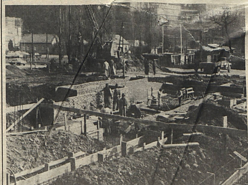
Jó ütemben halad a színház- és hangversenyterem építése a Kossuth Lajos utcában. A komlói dolgozók anyagi segítségével megvalósuló létesítmény, amely jelentősen növeli a közművelődési lehetőségeket, a következő tervidőszak első felében kerül átadásra. Fotó: Kóródi
