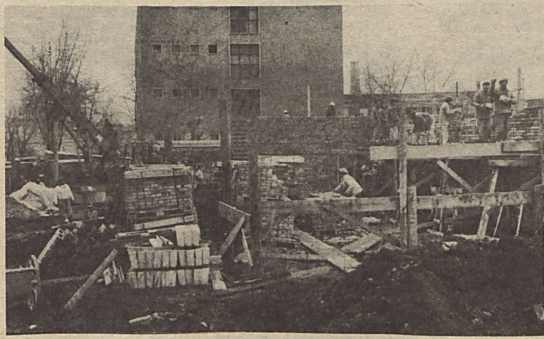
A fogadószintet és az alapozási munkákat végzik a Karbantartó Üzem dolgozói a Ságvári Endre utcai 45 lakás építésén. A szakmunkásképző intézet mellett megvalósuló beruházás — a bányász-lakás-építési program részeként — jövő év decemberében fejeződik be. Fotó: Kórádi
