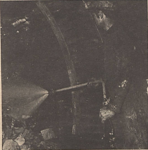
Vágathajtásban a jövesztett készlet permetezése felrakás előtt Fotó: Vékény
