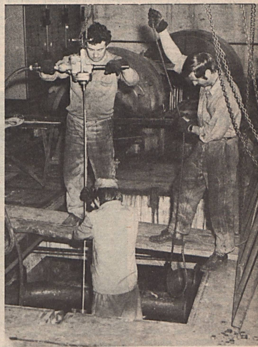
Az István-aknai aranykorszerű légszűrő brigád tagjai a 1500 m 3 -es kompresszor utóhűtőjét javítják
