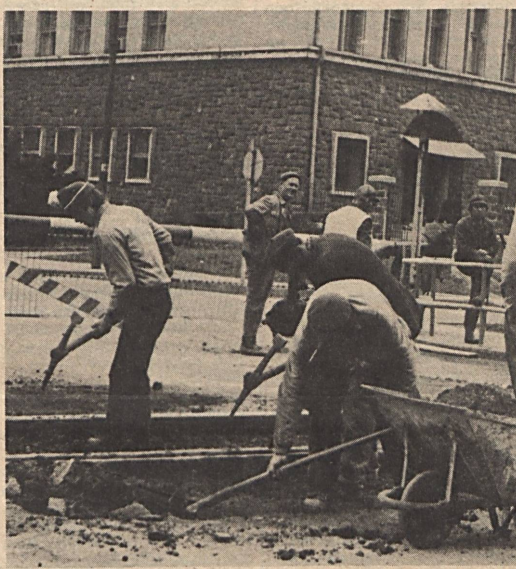
Az elmúlt hét közepén a Költségvetési Üzem dolgozói felújították a komló vasúti átjárót, Nem tudjuk azonban az autósok öröme teljes lehet-e, ugyanis alig került helyére az új betonpálya, amikor megindult a forgalom. Vajon meddig megyünk át sokat szidott vasúti átjárókon zökkenőmentesen?
