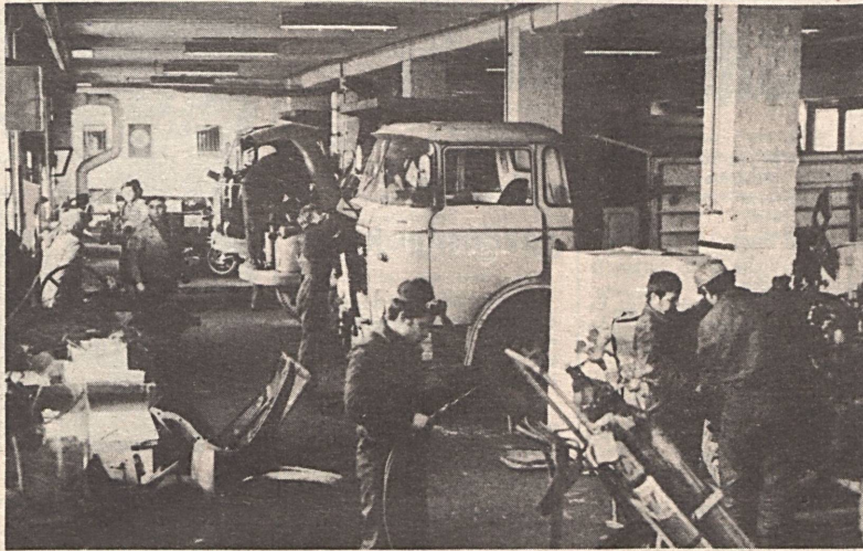
A teherszállító járművek 7—800 kilométerenkénti futóműjavítását végzik a Volán komlói üzemegységénél Kóródi Gábor felv.
