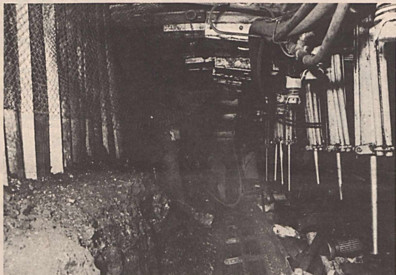
A SOW-fejtést még hálával is védik az omlások elkerülése miatt
