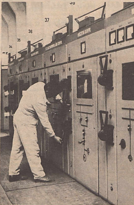
A 35 LV-es kapcsolódór, amely az István-aknán villamos energia elosztást biztosított teljesíteni
