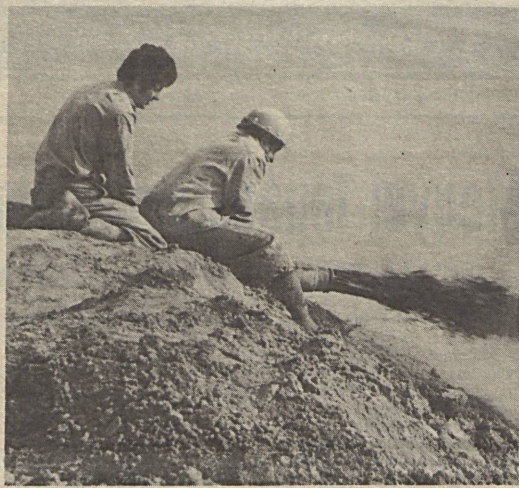
A nagy teljesítményű MIXOKRÉT berendezés ágyként lövelli a habarcshoz hasonló vegyi anyagot a füstölög felületre. Fotó: Beck Péter
