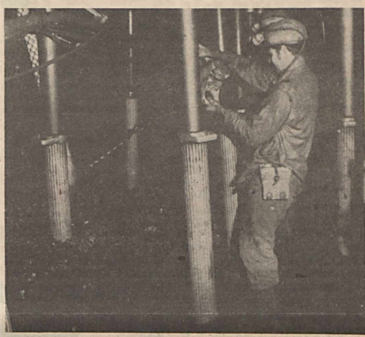
Lyukszelelés nagynomáshú, süritett levegős jóvesztéshez.
