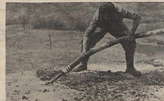
A tűz- és saválló masszát tömlővel terítik szét.
