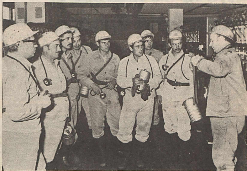
Farkas László, Zobák-bánya szervezési csoportvezetője (a képen jobbról) oxigénes menekülőkészítő lélek alkalmazását mutatja be a katonavendégeknek a bányajárás előtt. Tudósításunk a 2-es oldalon.
