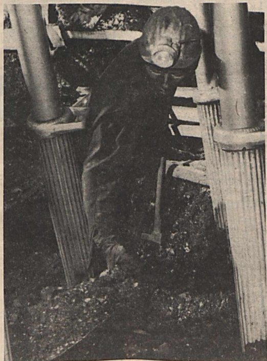
A biztonságos munkavégzés alapvető feltétele a vágat állapotának rendszeres tartása. Képviselet: talpszedés. Fotó: Nemesi
