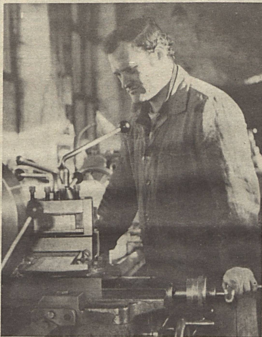
Böhl Tibor, az István-aknai műhely dolgozója csillefordító görgőt esztergályoz.
