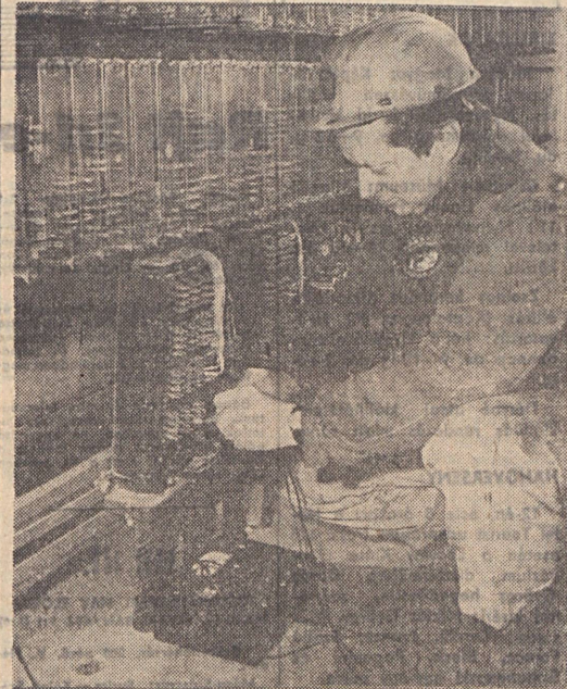
Földesi László integraszerező, 1954-től dolgozik a vállalatnál, a Kossuth-bányai „Gagarin” szocialista brigád tagja. Képünkön műszeres ellenőrzést végez a napisítai és sósóti integrá-berendezés vonalának kábelén.
