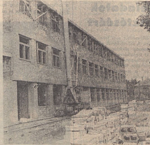
Az Építési Üzem legjelentősebb munkája, a Dobó utcai szakközépiskola
