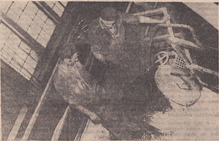
Az Újhegyi Üzemben az utósűrítő tartályok feletti vegyszerbekeverő, az úgynevezett flokutátor ellenőrzését végzik a berendezés kezelői.
