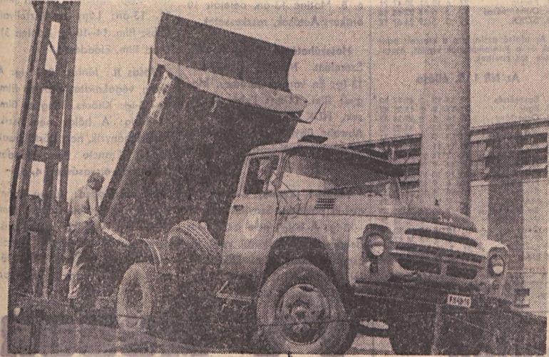
A gépkocsium az átlagosan 8 terepgepkocsit és 2 rakodógépet üzemeltet a Széchenyi-aknai külfejtésén. A gépkocsi napi 1500–1600 tonna szént szállítanak a külfejtéstől mintegy 2 km-re lévő bányához. A bányából ömlő szén osztályozórácson keresztül kerül a szállítószalagra.
