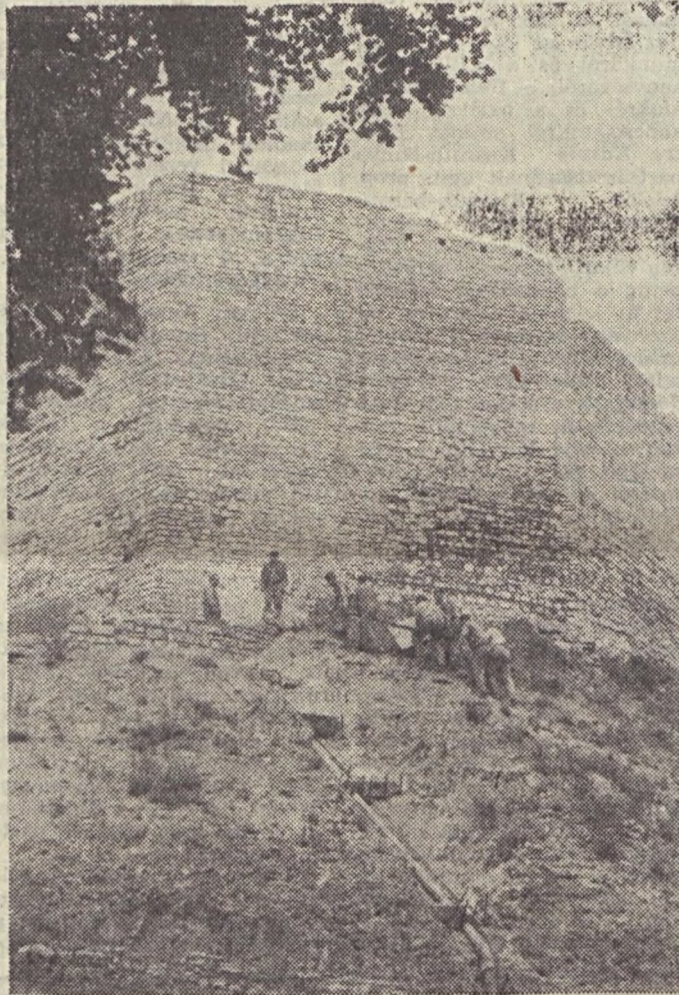
A Kossuth-bányaiak a vízvezetékét építik
