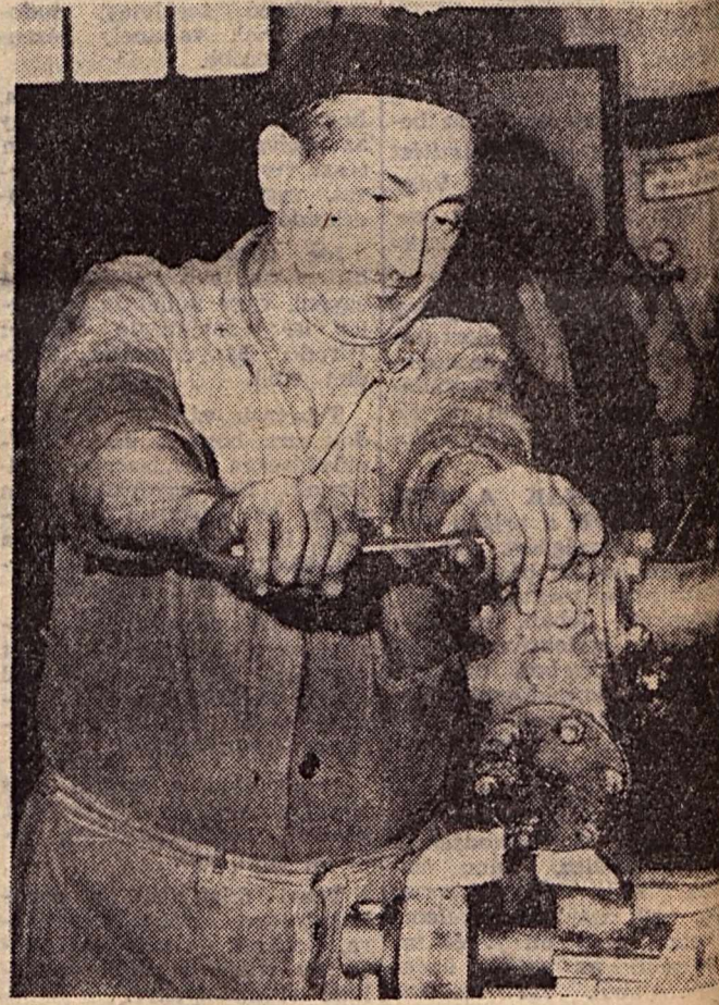
Kovács Ferenc a kormánymű ellenőrzését és beállítását végzi
