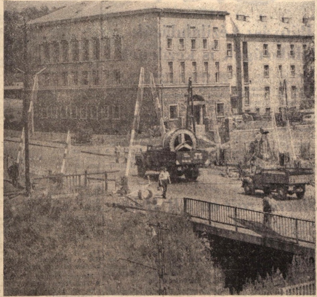
Komlón, a Pécsi út szélesítésével párhuzamosan szükségessé vált a meglévő vasúti sorompó kiterjesztése is. A napokban ez a munka befejeződött. Az új sorompó két-szárnyú, kezelése üzembiztosabb a régivel. (Ha már a sorompóknál tartunk, hadd említsük meg, hogy a rossz nyelvek véleménye szerint ez a biztonsági berendezés feleannyiba sem került, mint a Széchenyi-aknai. Igaz, ez nem motorral jár, de működik.) (Császár Zoltán felvétele)
