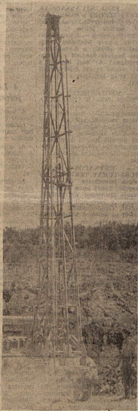
Az összefüggő körétegeket előbb megfűrik majd szétrobbantják. Ez a geológiai fűróberendezés több száz méter mély lyuk fűrására alkalmas.
