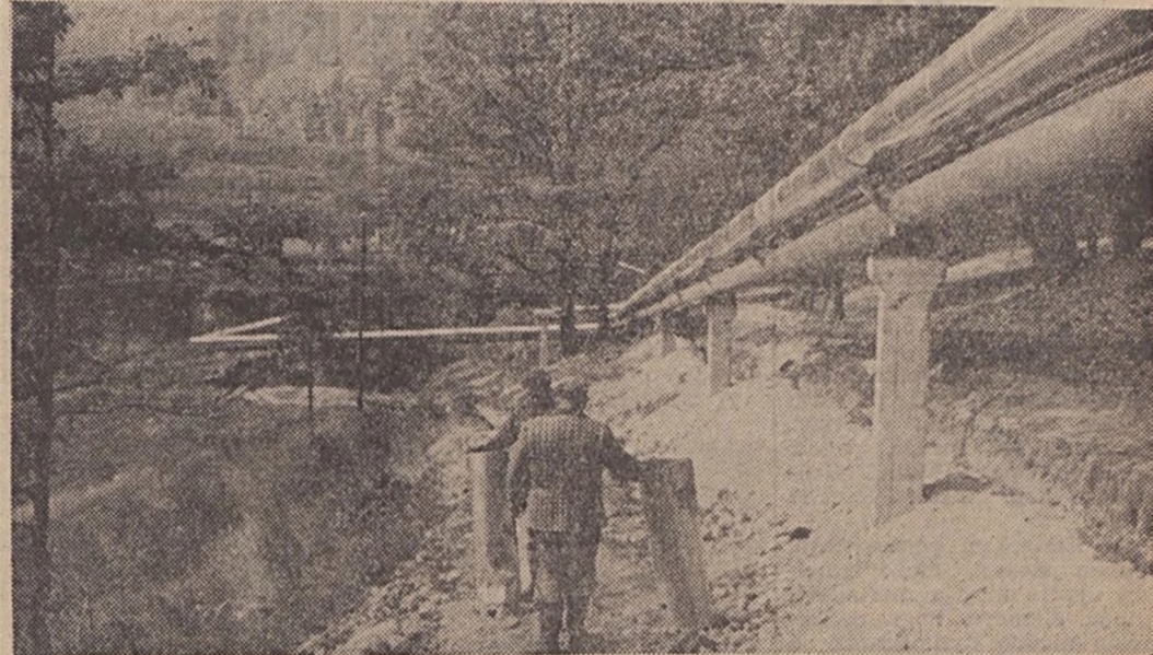
A Hídépítő Vállalat elkészítette az üzemet az Erőművel összekötő csaknem 4 kilométer hosszú távfűtő-vezetékét. Ezzel használhatóvá válik a háromezer személyes, ultramodern fürdő és a korszerű irodaépület.
