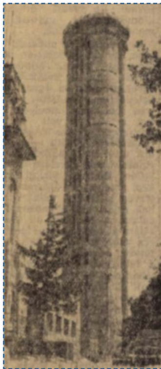
A 70 méteres tévétorony építési fázisa, még a presszósztint elérése előtt (Dunántúli Napló, 1968. június 16., 4.)
