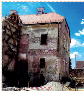
A felújítás kezdeti lépései. Forrás: Középkori élet a várkastélyban MNV
