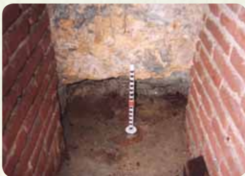
5. sz. melléklet: a Bazilika altemplomának északi fala alatt agyagpalcölöpökkel végzett talajszilárdítással
