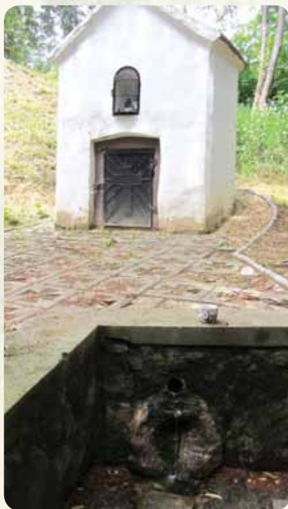
6. sz. ábra: A foglalás felépítménye és előterében a támfalba épített kifolyási hely
