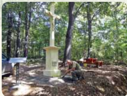
Felújítás közben Baumann József BJ
