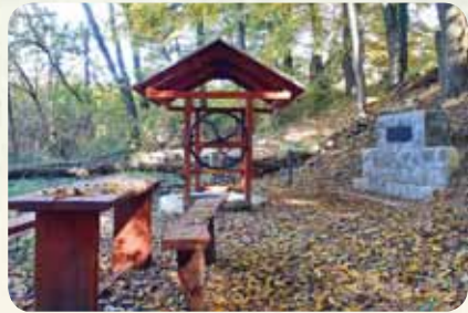
A felújított kút BJ
