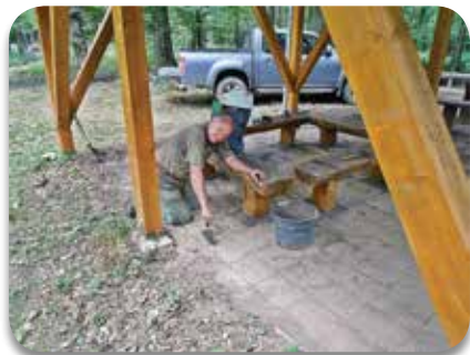
A Cinke-tanya emlékhely karbantartása, padlábak betonozása
