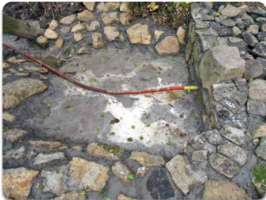
Elkészült a forrás falazása
