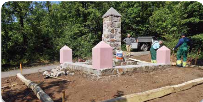
Munkavégzés ellenőrzése (háttul Szilasi Tamás parkerdő gazdálkodási részlegvezető)
