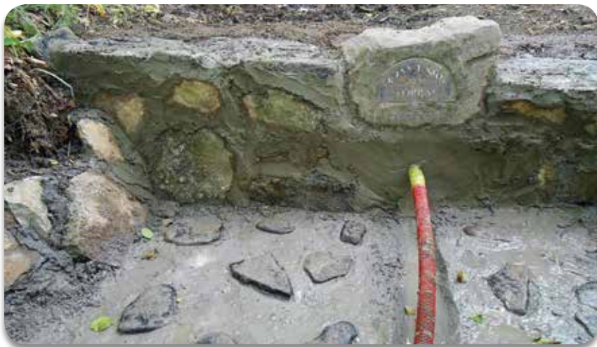
A forrás falzatának fugázása
