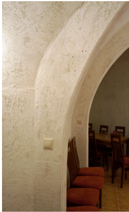
Hengerpalást és az ellipszoid szerkezet találkozása
