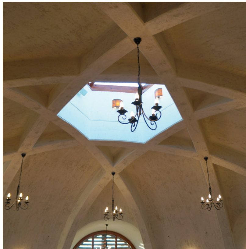
Látszóbeton szerkezet
