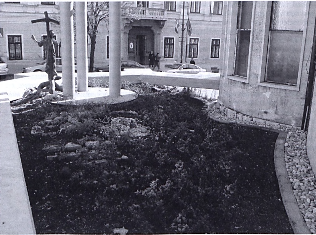
A templom falának sem a múdomb, sem a vasbeton szerkezet nem csatlakoztatható korrekt módon, és ez ordító. A részletek megoldatlanok, a templom ablaka félig a kavicsba került.
