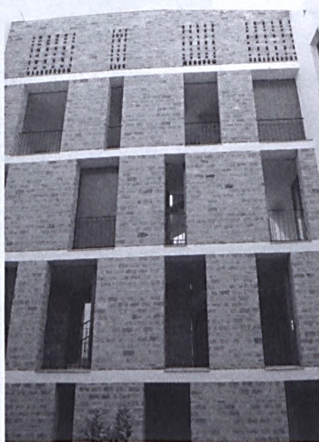
"HIDLEPCSŐ" NEZETE A BELSŐ UDVAR FELŐL A LEGFELSŐ SZINT TEGLAKOSZTÁSI JAVASLATA AZ ESETLEGES KLÍMAGEPEK KISZELŐZTETÉSÉNEK LEHETŐSÉGÉT A "LYUKAS" HOMLOKZATON KÉRSZTŰL LEHET MEGOLDANI A TEGLAFAL BELSŐ OLDALÁN A MADÁRAK STB. ELLEN. RÖVIRÁHILÓT KELLENE FELTENNİ A MÁS SZÍNŰEL JELELT TEGLÁK A "SZABVÁNYOS" (1/4, 1/2, ILL. EGÉSZ) TEGLÁKTÓL ELTÉRŐKÉNT JELENTIK. M=1:50
