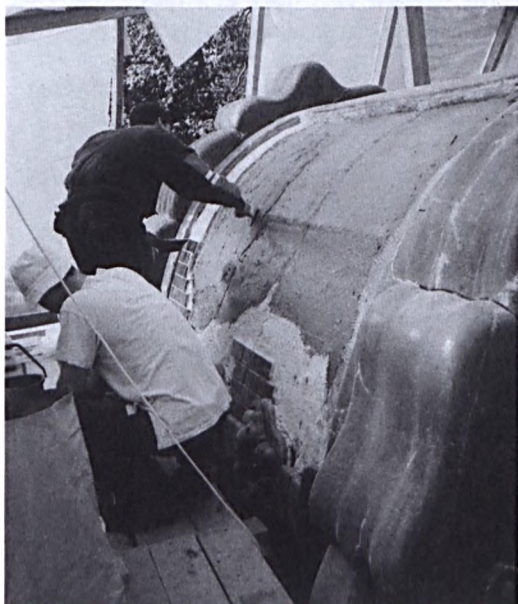
Helyreállítás előtti állapotban a külső burkolati elemek sok helyütt lehulltak, összetörték...
