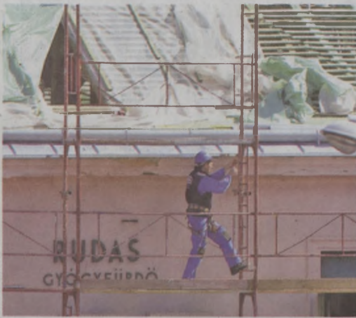
A Rudas fürdő belülről már megszépült, idén a homlokzat felújítása jön
