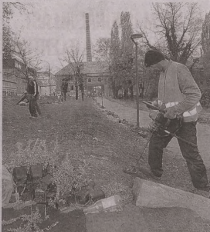
A rézsű parkosítása is megkezdődött a minap a Balokányban
