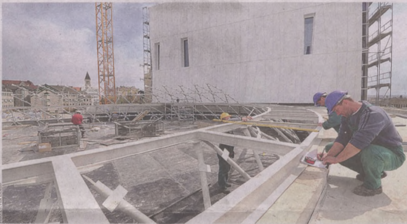
Kívülről már egyre inkább hasonlít az épület formája a terveken látottakra - a pótmunkák miatt csúszhat a műszaki átadása kezdete
