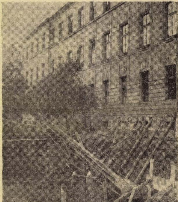
A Dózsánál létesülő egyetemi elméleti tömb mellett dezaktiváló berendezést építenek. A földalatti betonartálysorba engedik majd a kutatások során keletkező, izotóppal fertőzött szennyvizet, amit csak akkor engednek majd a szennyvíztisztítóba, amikor a sugárdózis veszélyes szint alá süllyed.
