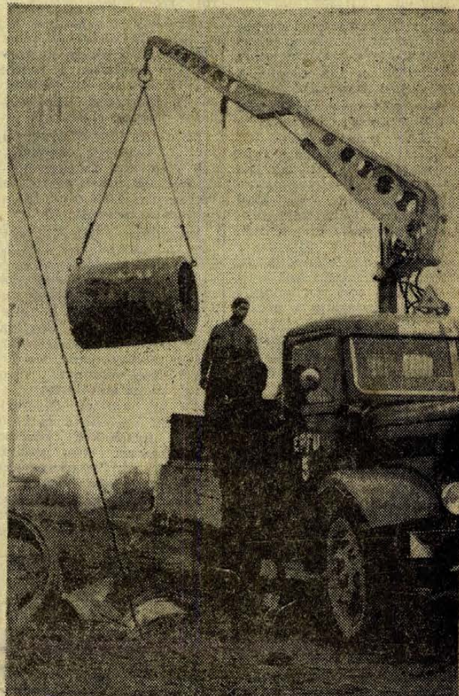
Három ember rakodómunkáját takarítja meg a gépkocsira felszerelt gölyadaru, s a rakodási idő felére, 15 percre csökken. (A szerelést maguk végezték, jelenleg három ilyen gépkocsija van az ÉPÜ-nak.) Nehéz fizikai munkát takarítanak meg ezzel, jobb a gépkocsik kihasználtsága, kisebb az építőanyag törési százaléka. A darut a gépkocsivezető kezeli. A képen: kútyűrűk rakodása közben Mohácson.
