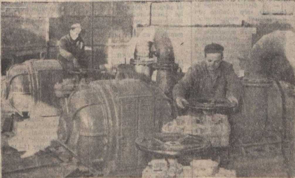
A mohácsi vízkivétel nagynyomású szivattyúháza.
