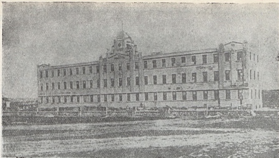
A gyártási épület (1911)
