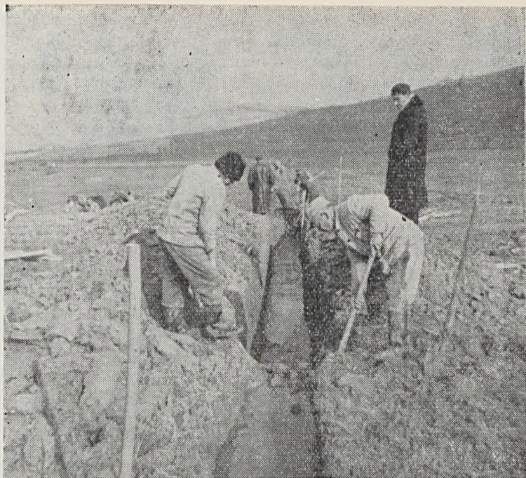
Forrásfoglalás, csőlehelyezés Felsőszentmártonban
