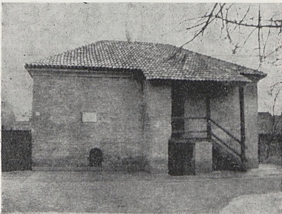
A helyreállított épület
