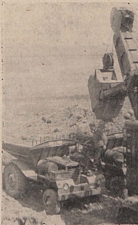
Hatalmas gépekkel kezdik el az új vasútvonal építését
