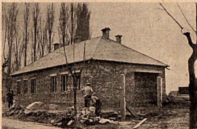
Az építés alatt lévő Pécs-kertvárosi tanítói ikerház
