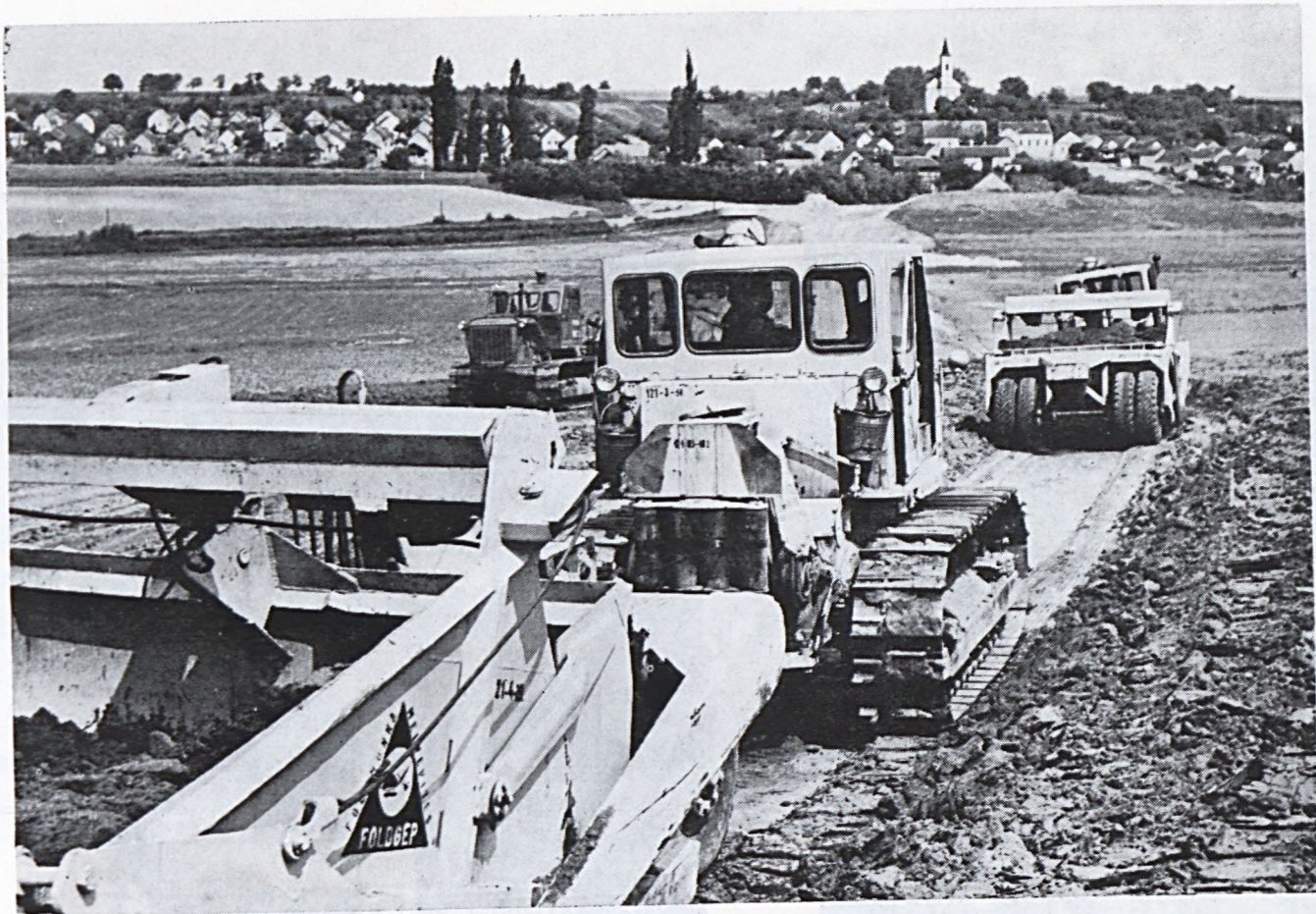
Bekötőt épül Újpetre és Pécsdevecser között
