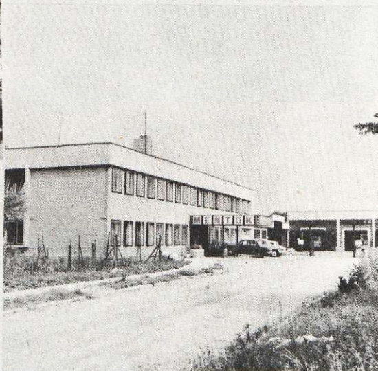
Mentőállomás.Kaposvár. /1967/ Építész:Freifogel Mihály
