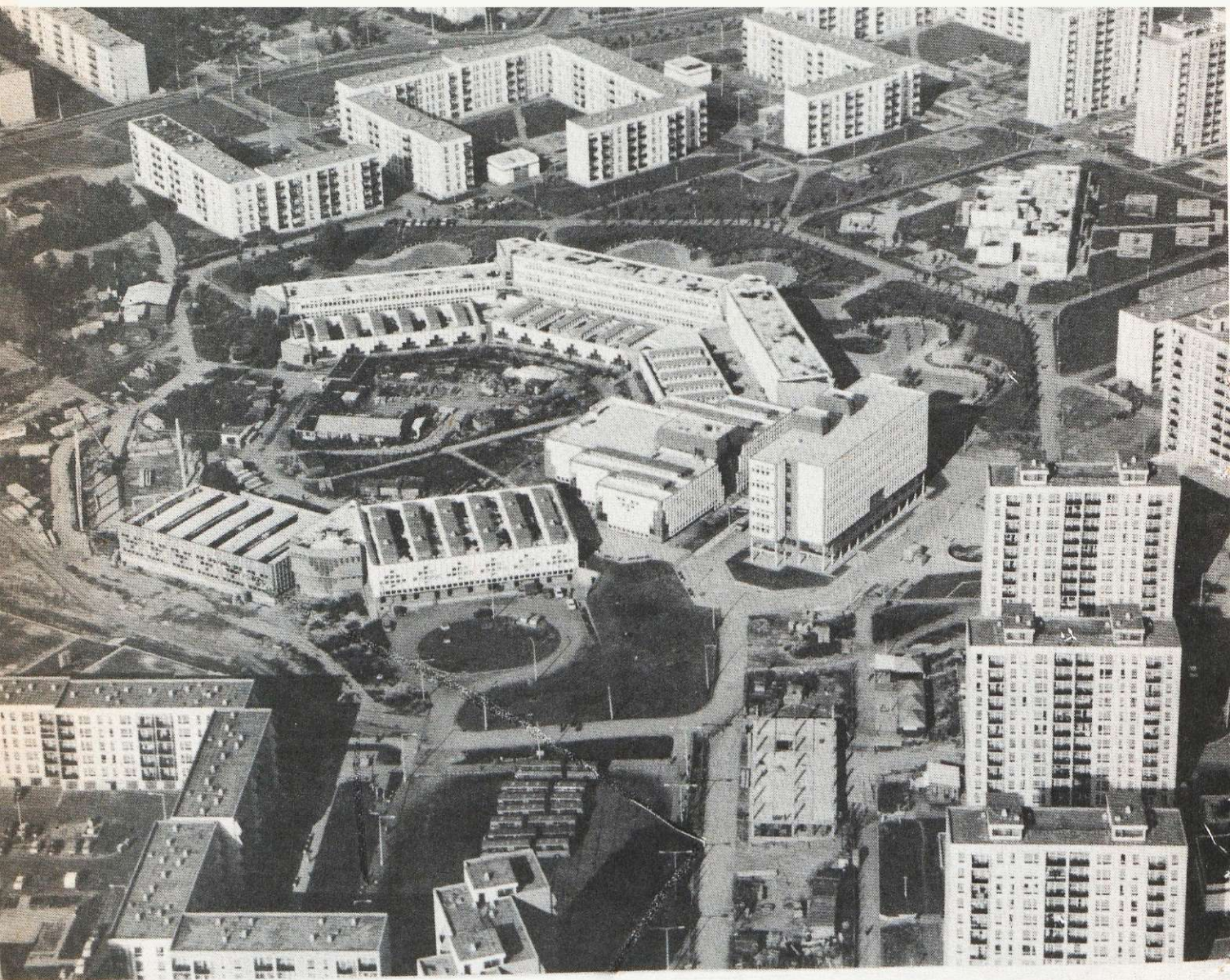
Nevelési Központ és környezete. Pécs, L'vov kertváros/1978/ A Nevelési Központ építész tervezői: Jankovics Tibor és Tóth Koltán
