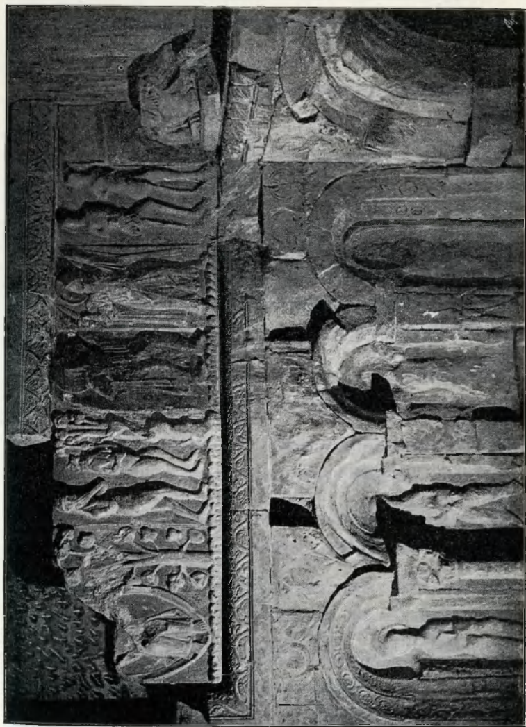
62. Az északi katakombalejárat északi fala.
