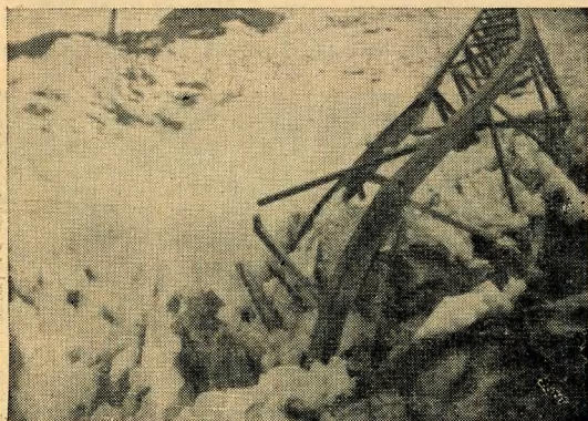
14. ábra. A vihar által betonalappal együtt kiszakított vasoszlop a Pécs-Szentlőrinc országúton.
