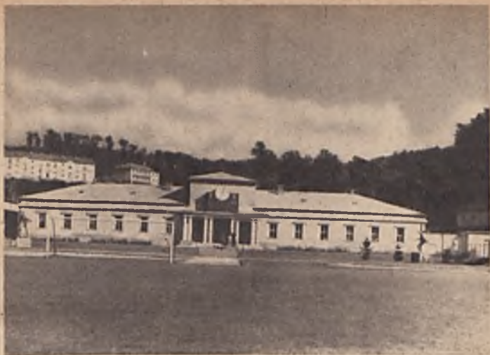
A STADION FŐÉPÜLETE
