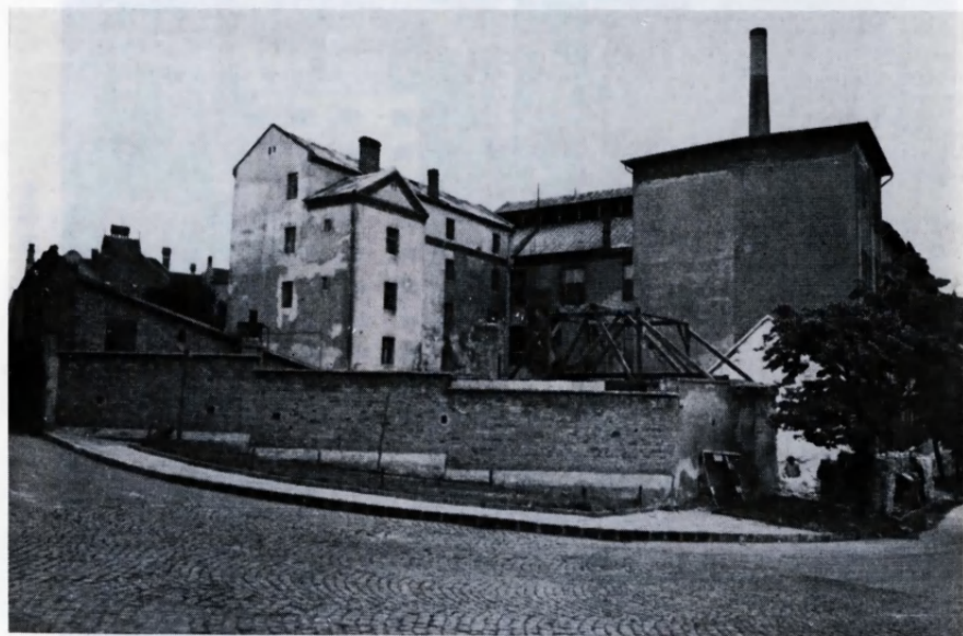
1963-ban kezdõdött el a főzõbáz építése az alapanyagraktárak helyén. Két év múlva már üzemelt
