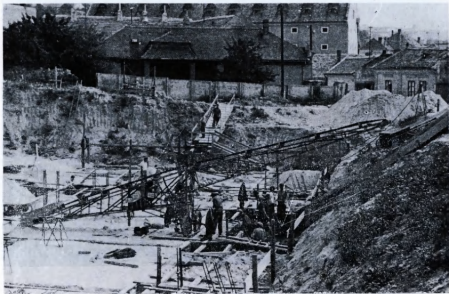
A nyolcvanmilliós rekonstrukció – amelynek során az erjesztő és ászokblokk is készült – 1967-ben kezdődött el
