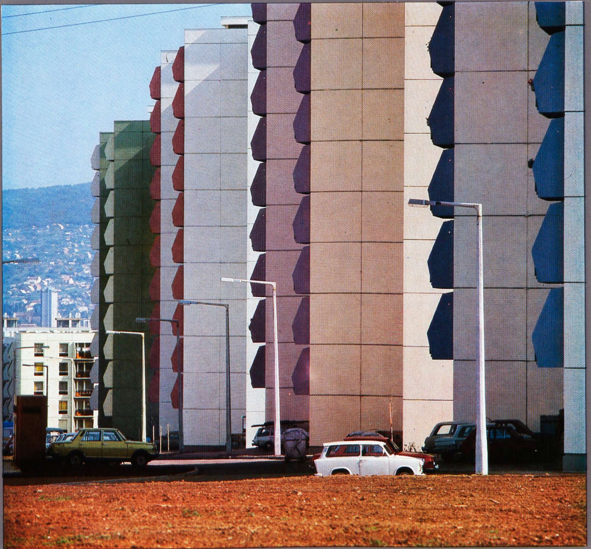
8. Pécs, paneles lakóépületek Építész: Pálmai István
