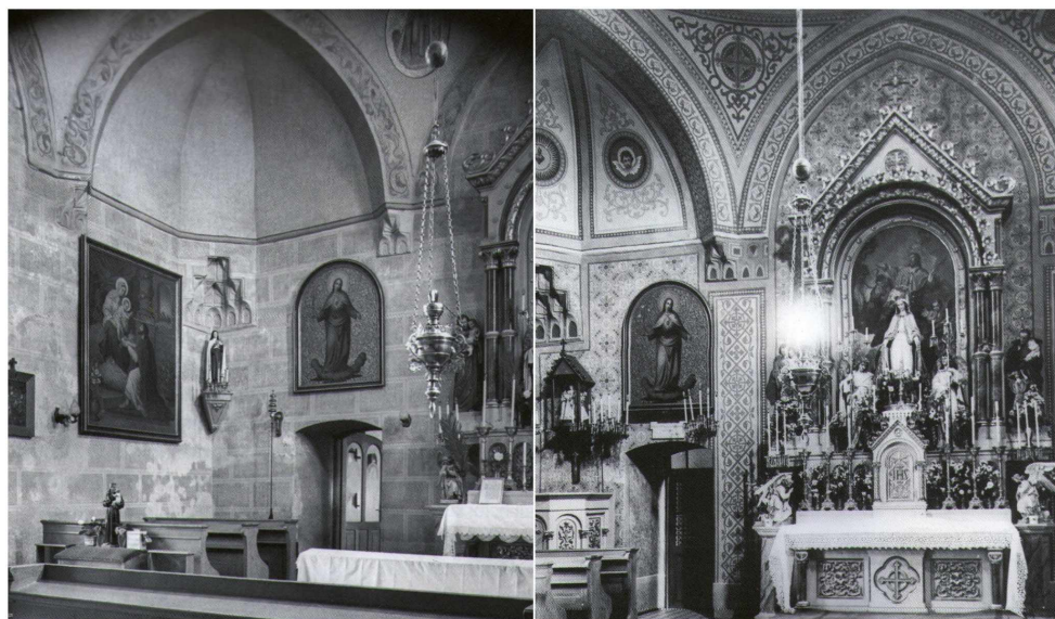
6–7. kép A Nepomuki Szent János kápolnabelső az 1895-ös felújítás előtt és után (Forrás: Sudár 2010, 78; KÖH Tervtár Ltsz. 5478.)
