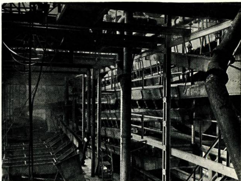
11. Részlet a pécsújhegyi szénosztályozó gépi berendezéséből.
