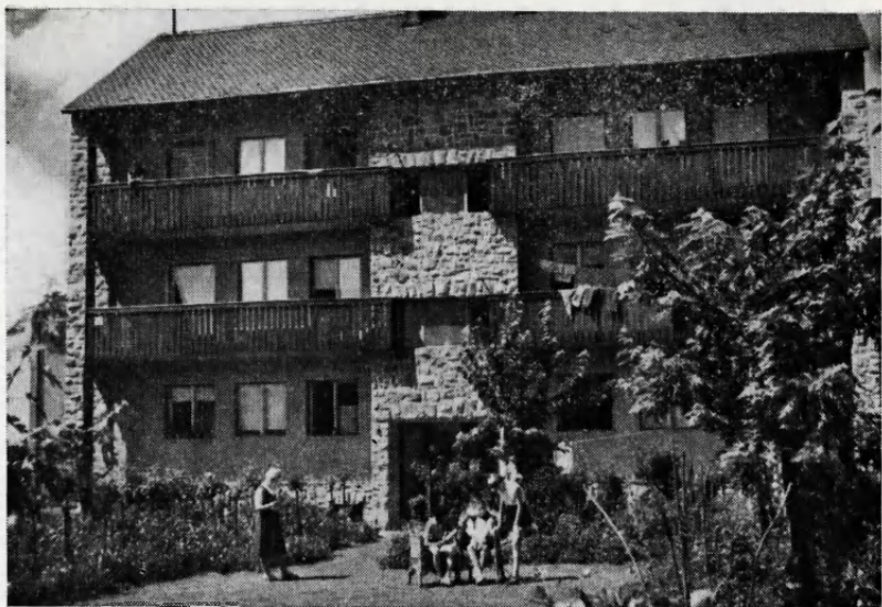
21. A népi demokratikus időszakban elsőként megépült munkáslakóházak egyike
