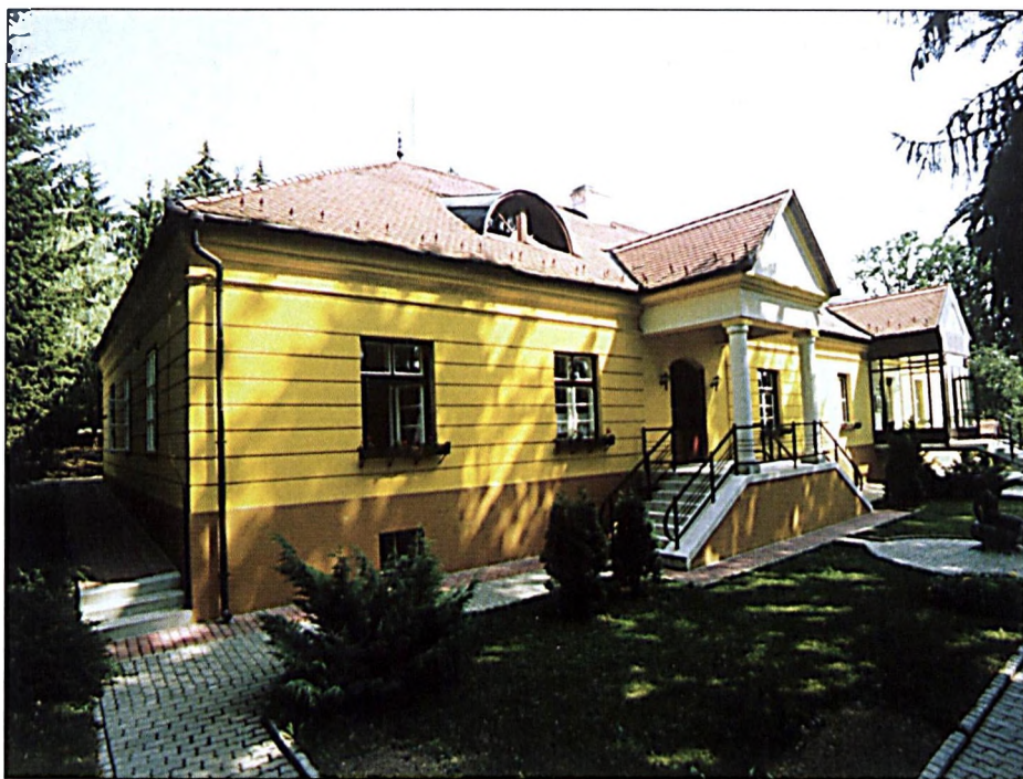
A DÉLHÚS Rt. vendégházának (a volt Sztankovánszky-kastélynak) nyugati homlokzata
