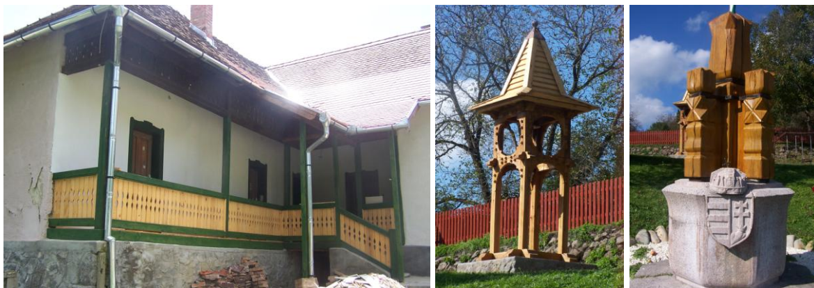
A felújított iskolaépületben több közösségi funkciójú terem is van.
