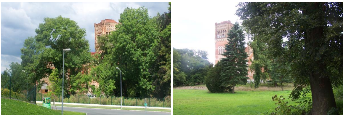
Az Erdődy-kastély és kertje. Az épület felújítás alatt áll.
