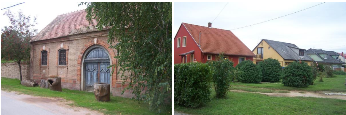
Helyi építőanyag felhasználásával készült ház az ófaluban, újonnan épült házsor a Cserkút felé vezető utcában.
