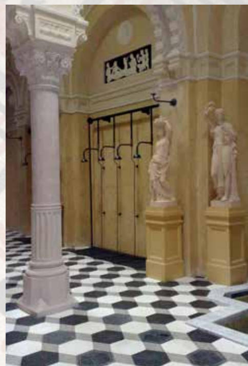
Rác-fürdő Ybl csarnok, terrazzo rekonstrukció, Palazzo Kft.
